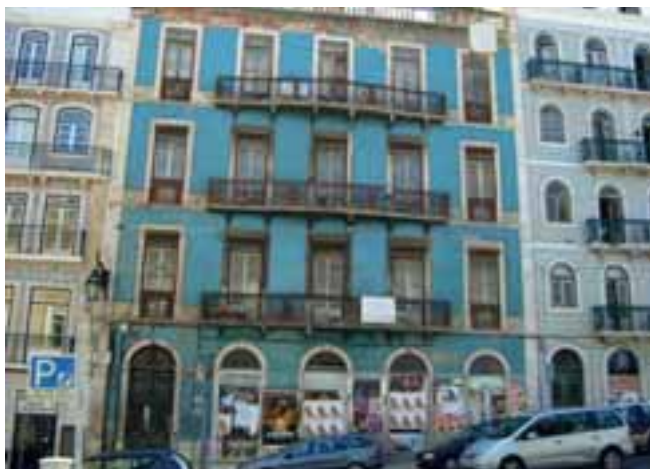
Largo Trindade Coelho n.º 9-1.º. De 1943 até 1947/48. Foto tirada antes da recuperação do edifício
