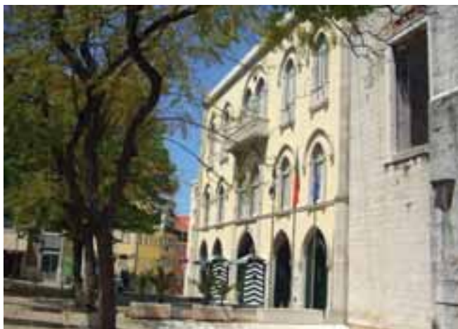
Edifícios onde funcionaram os serviços da Censura. Quartel da GNR do Carmo. Desde 22 de Junho de 1926 a 1934
